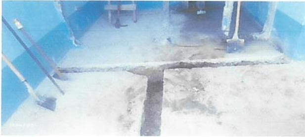
Foto 3: Reparación tubería de drenaje.
